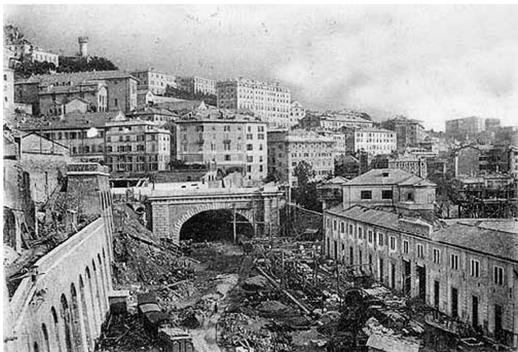
Lavori di costruzione passante Genova Principe e Genova Brignole
