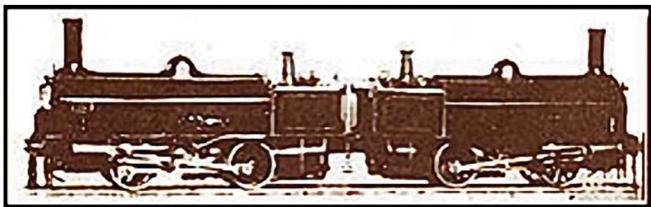
Locomotive Stephenson, denominate Mastodonti dei Giovi. Potenza 200x2 CV, velocità massima 35 Km/h. Utilizzate accoppiate per superare il Valico dei Giovi (25 per 1000).
